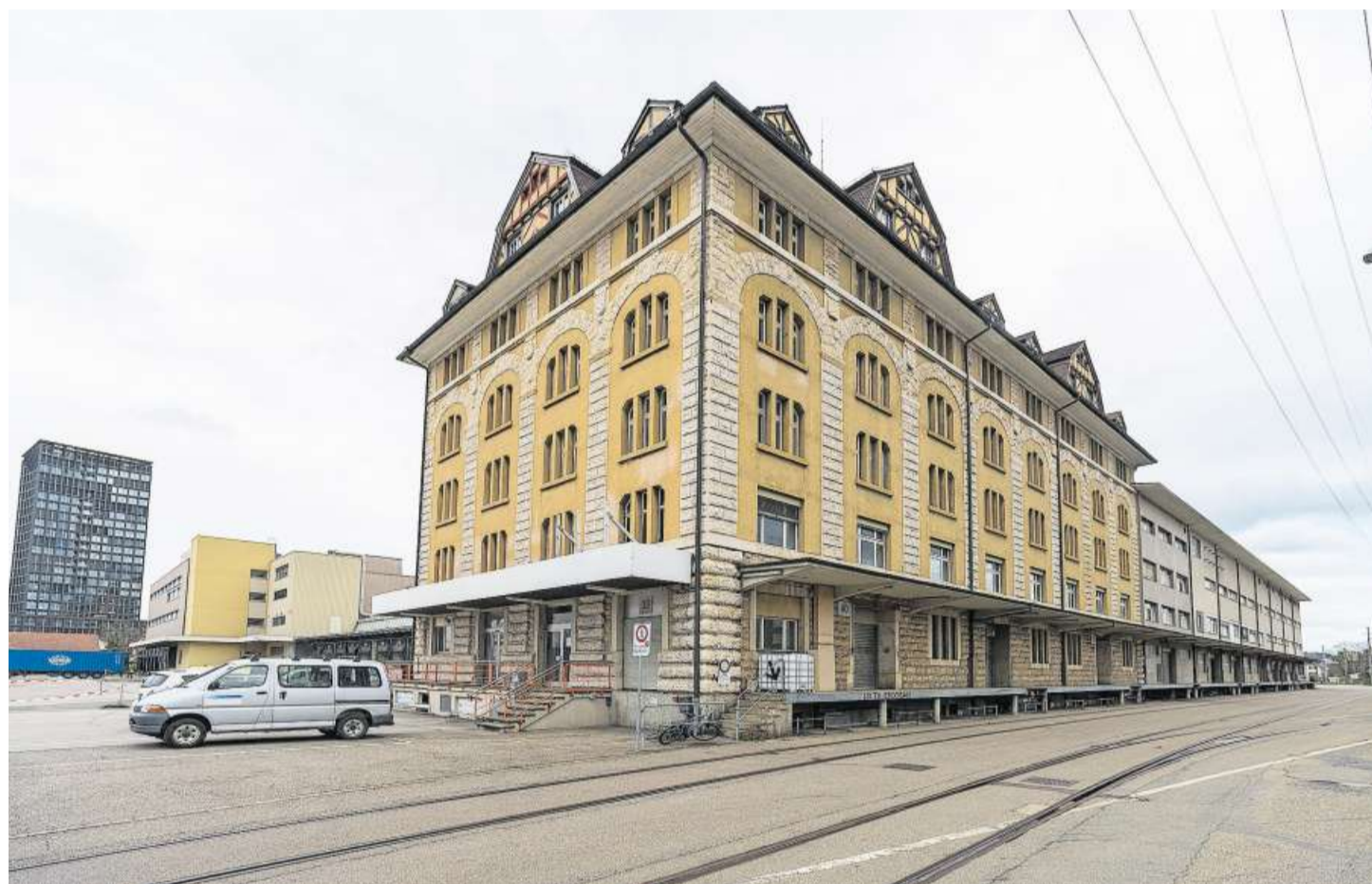
Grossprojekt für gemeinnützigen Wohnbau: Beim Prattler Bahnhof entstehen in den nächsten Jahren 480 Wohnungen. Bild: Kenneth Nars
